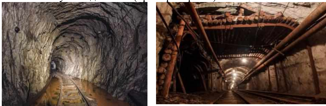
Рисунок 1. Общий вид шахты.
